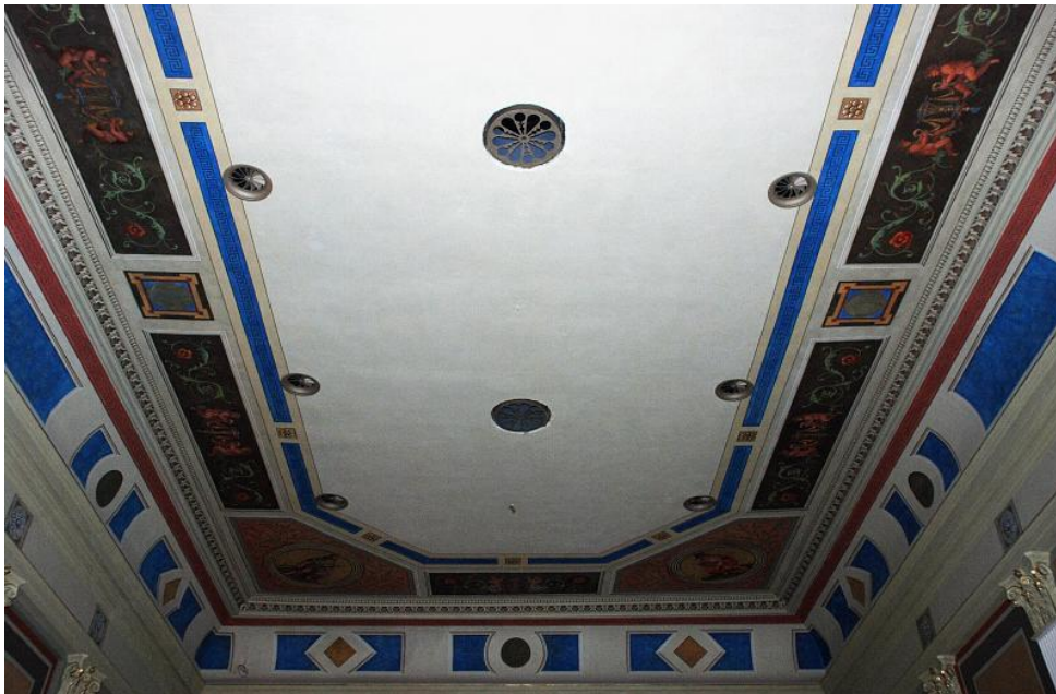
Pohled na strop Císařského sálu – po restaurování (před dokončením)
