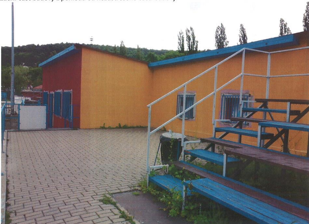
Pohled z pravé tribuny na zastřešenou část stavby
