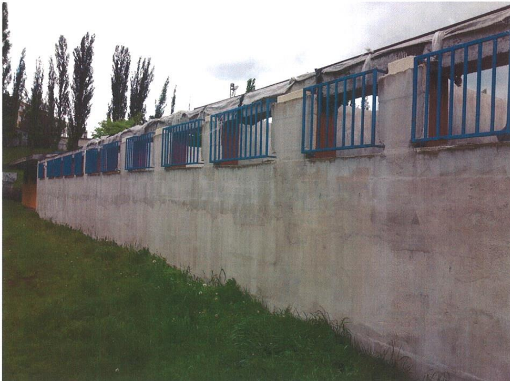
Zadní část budovy z pohledu od nezastřešené části budovy
