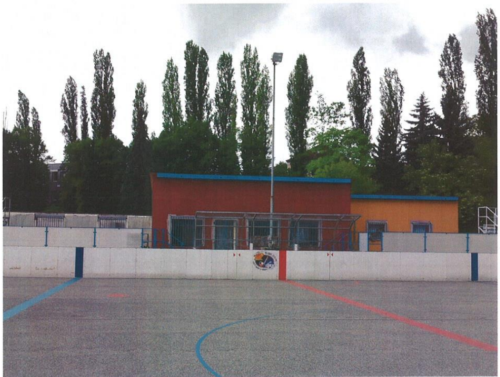
Pohled na rozestavěnou budovu z hokejbalového hřiště.
