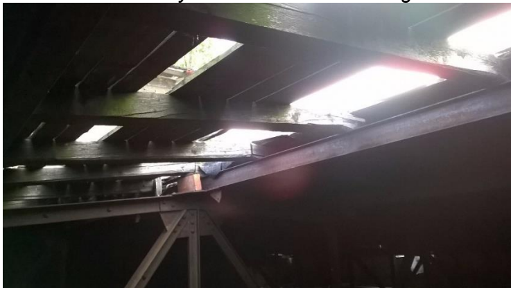
Obr.: Otvory ve střešním plášti
