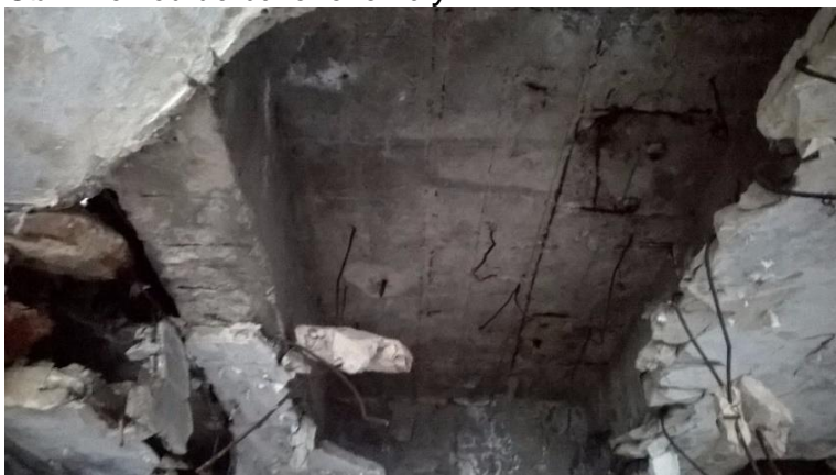
Obr.: Trámový betonový strop s betonovým podhledem
