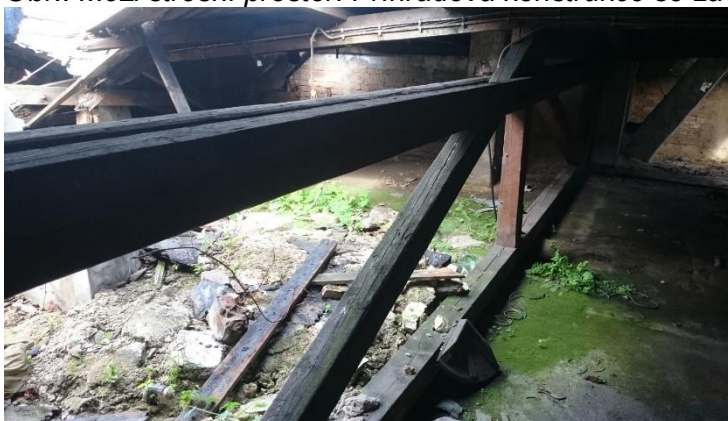
Obr.: Dřevěné věšadlo nad provozní částí (trakt směrem k ulici)
