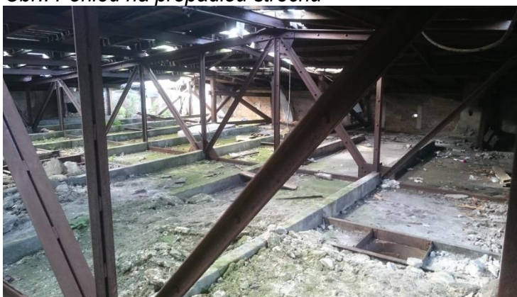
Obr.: Mezi střešní prostor. Příhradová konstrukce se zavěšeným podhledem.
