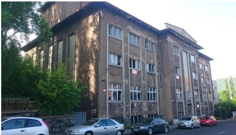
Obr.: Pohled na fasádu z ulice Truhlářova
