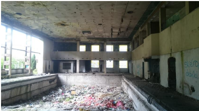
Obr.: Pohled do bazénové haly
