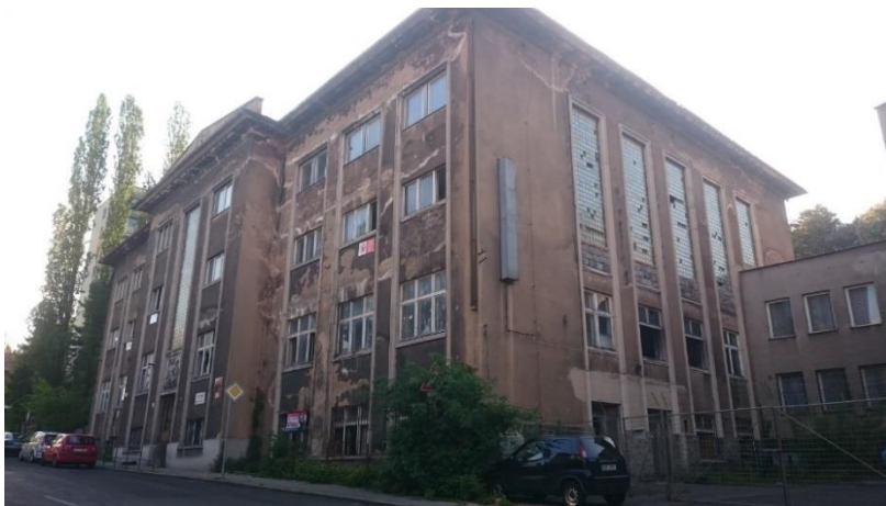
Obr.: Pohled na fasádu z ulice Truhlářova
