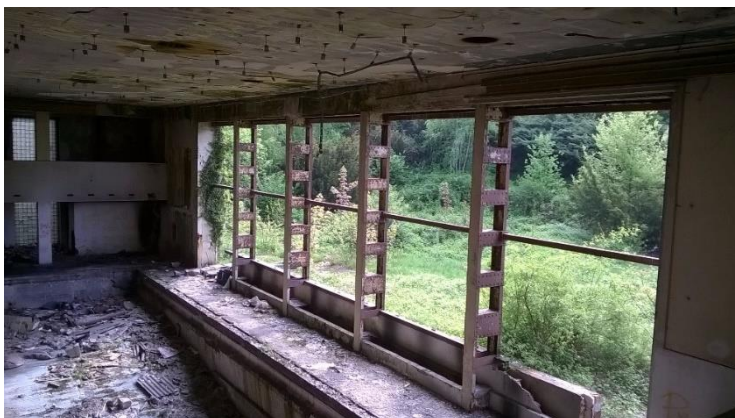
Obr.: Pohled do bazénové haly z ochozu ve 3.NP
