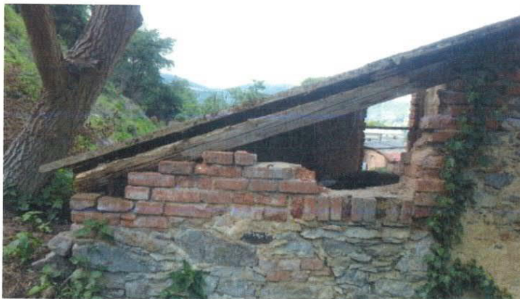
obr. 3 Střeška a jižní štít
