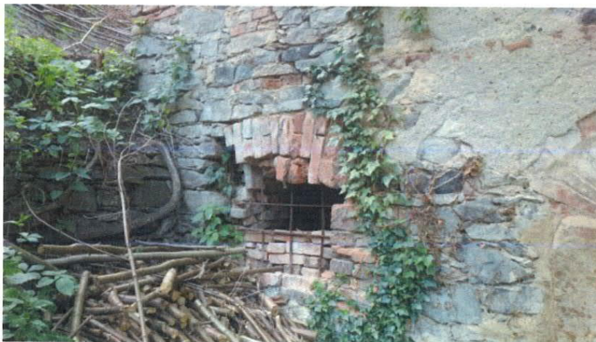
obr. 5 Okno v jižní fasádě
