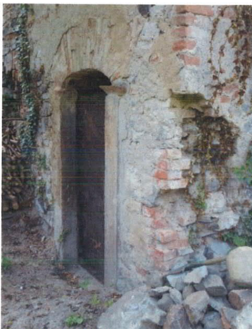
obr. 4 JV nároží objektu
