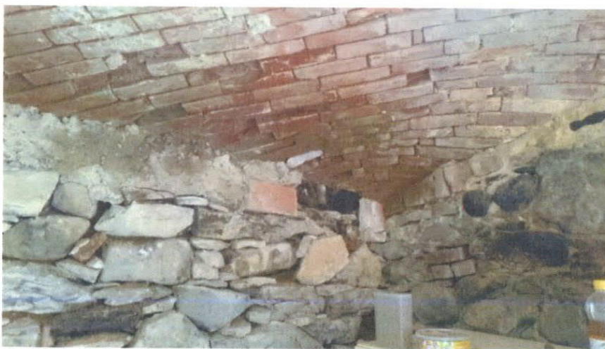
obr. 7 Pata klenby na kamenném zdivu západní stěny
