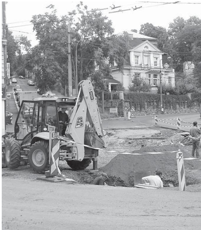
Stavba kruhového objezdu probíhá plynule bez zpoždění.
